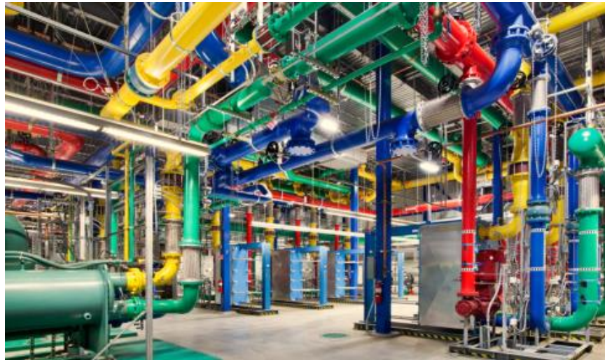
Abb. 4: Fluidsystem zur Kühlung eines Rechenzentrums der Fa. Google.
